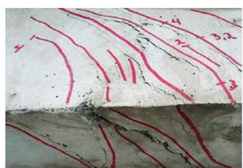
Бетон – материал, содержащий большое количество пор, объем пористой массы 10-15%, которые сезонно заполняются жидкой фазой. Циклы замораживания/оттаивания действуют как домкрат, постепенно разрушая защитный слой железобетона и обнажая рабочую арматуру.
